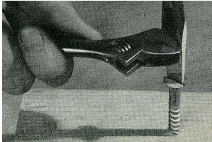
Hình 1.57. Cách sử dụng tuốc nơ vít kết hợp với mỏ lết.
