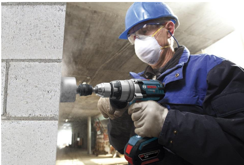
Hình 2.9. Trang bị đầy đủ quần áo bảo hộ khi khoan.
