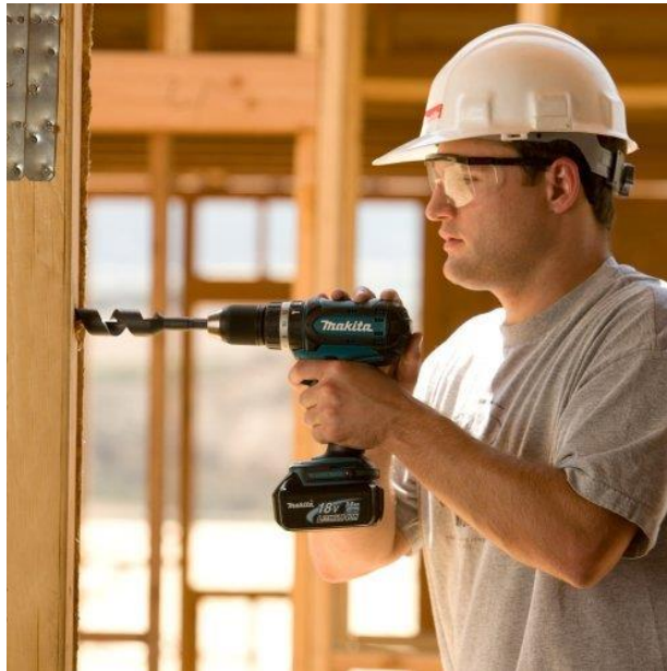
Hình 2.7. Bảo vệ mắt khi khoan.
