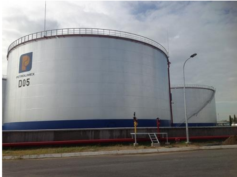
Hình 1.23. Kho chứa xăng, dầu tiêu chuẩn
