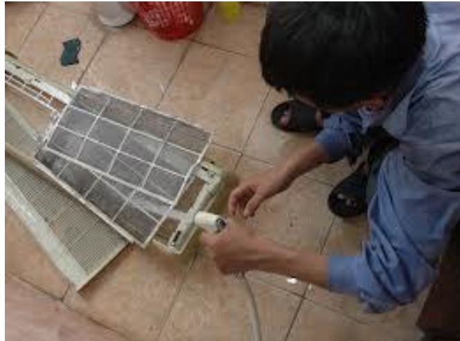
Hình 16.12. Vệ sinh lưới lọc
