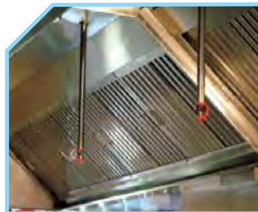
KIỂM TRA LƯỚI LỌC CỦA QUẠT THÔNG GIÓ XEM CÓ SẠCH KHÔNG 14
