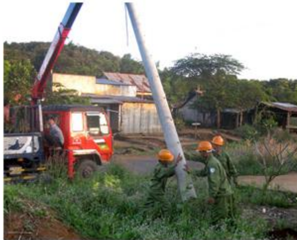
Hình 3.2. Dựng cột bằng cần cẩu
