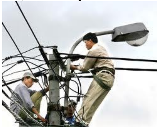
Hình 3.7. Công nhân lắp đèn chiếu sáng đô thị
