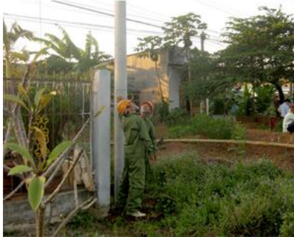
Hình 3.3. Chỉnh cột thẳng đứng
