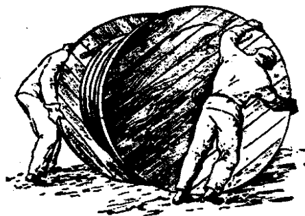
Hình 2.2. Lăn vận tang lô cáp
