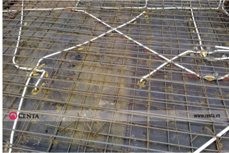
Hình 5.10: Đi ống âm trong trần nhà
