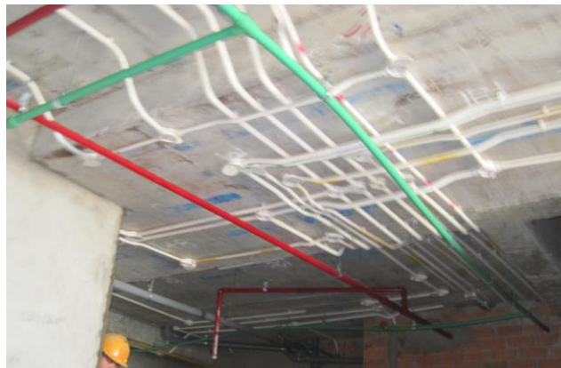
Hình 5.11: Đi ống trên trần nhà trần nhà
